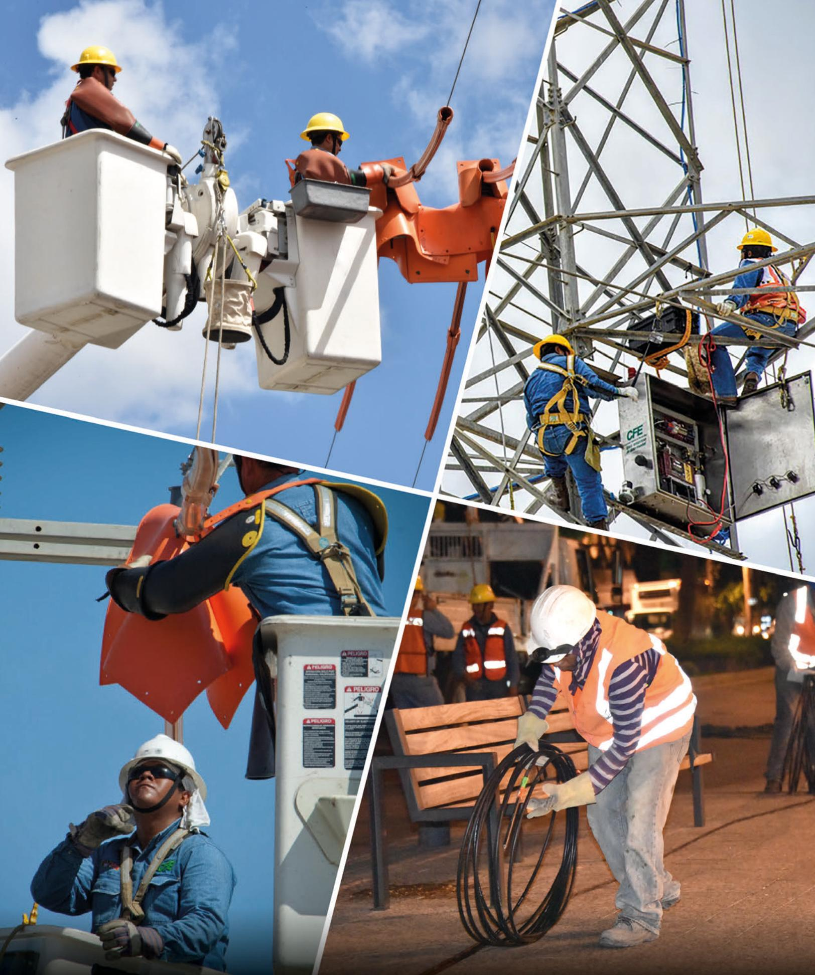
**Fotografía 21.** Instalación de dispositivo para tirado de conductores en alta tensión. Colocación de protectores a línea. Cableado Centro Histórico, CDMX. | Comisión Federal de Electricidad.
